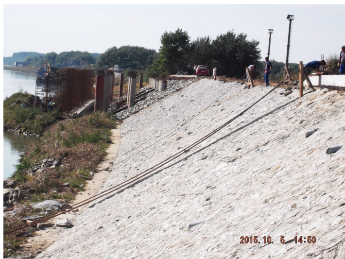
Realizare grindă de coronament (închidere pereu)
