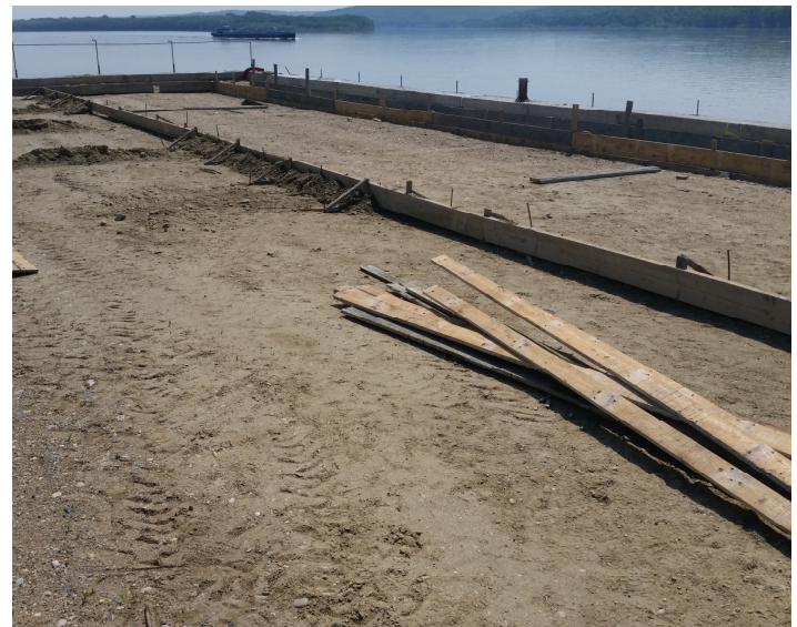
Cofrare placă de închidere
