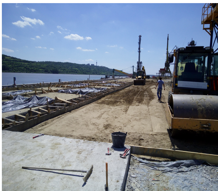
Execuție placă din beton
