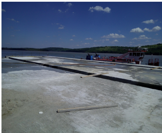
Execuție placă din beton
